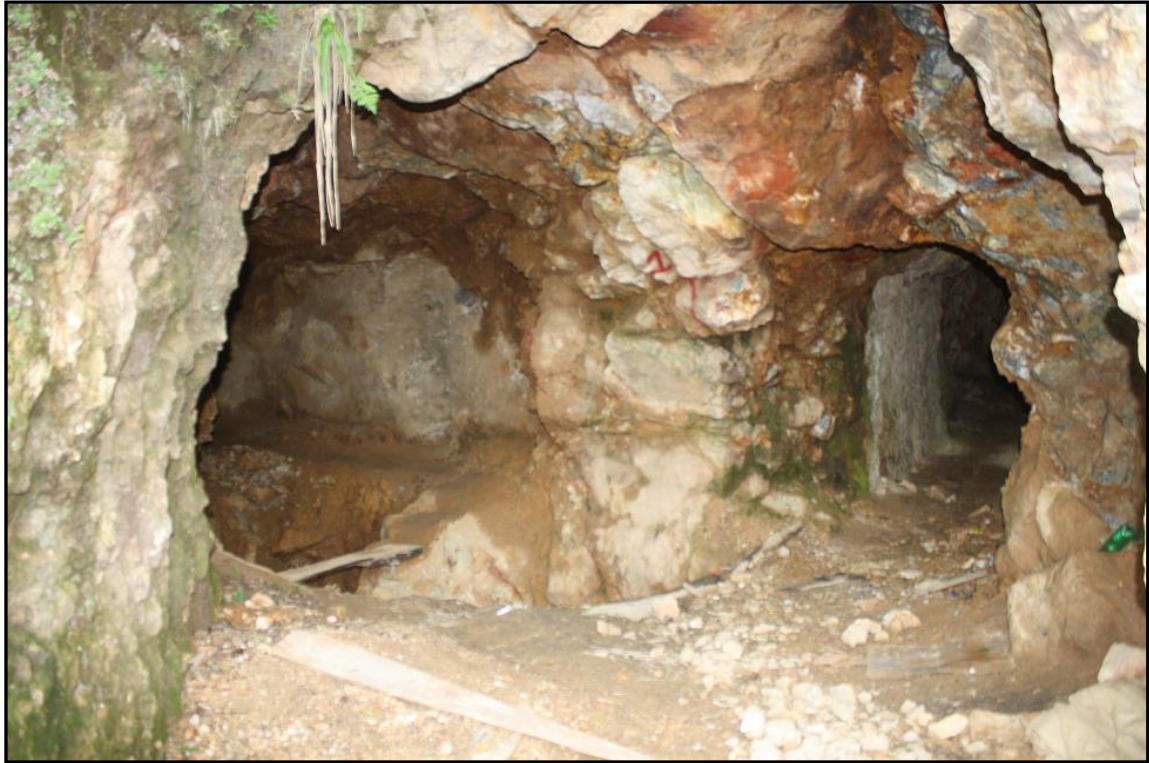
Fig.30: Túnel La Garroba, túnel realizado por mineros artesanales de la zona, se ubica a un nivel superior del nivel 7 de la mina Tres Hermanos
